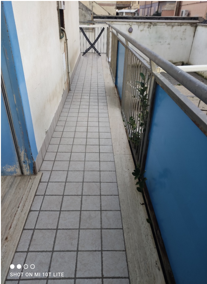
Foto 10-11: Balcone e stralcio cortile con scala di accesso
