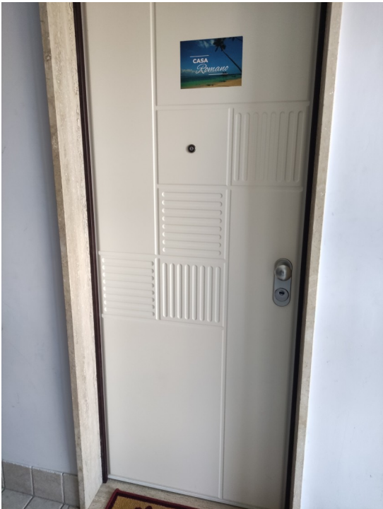
Foto 3: portoncino di ingresso
